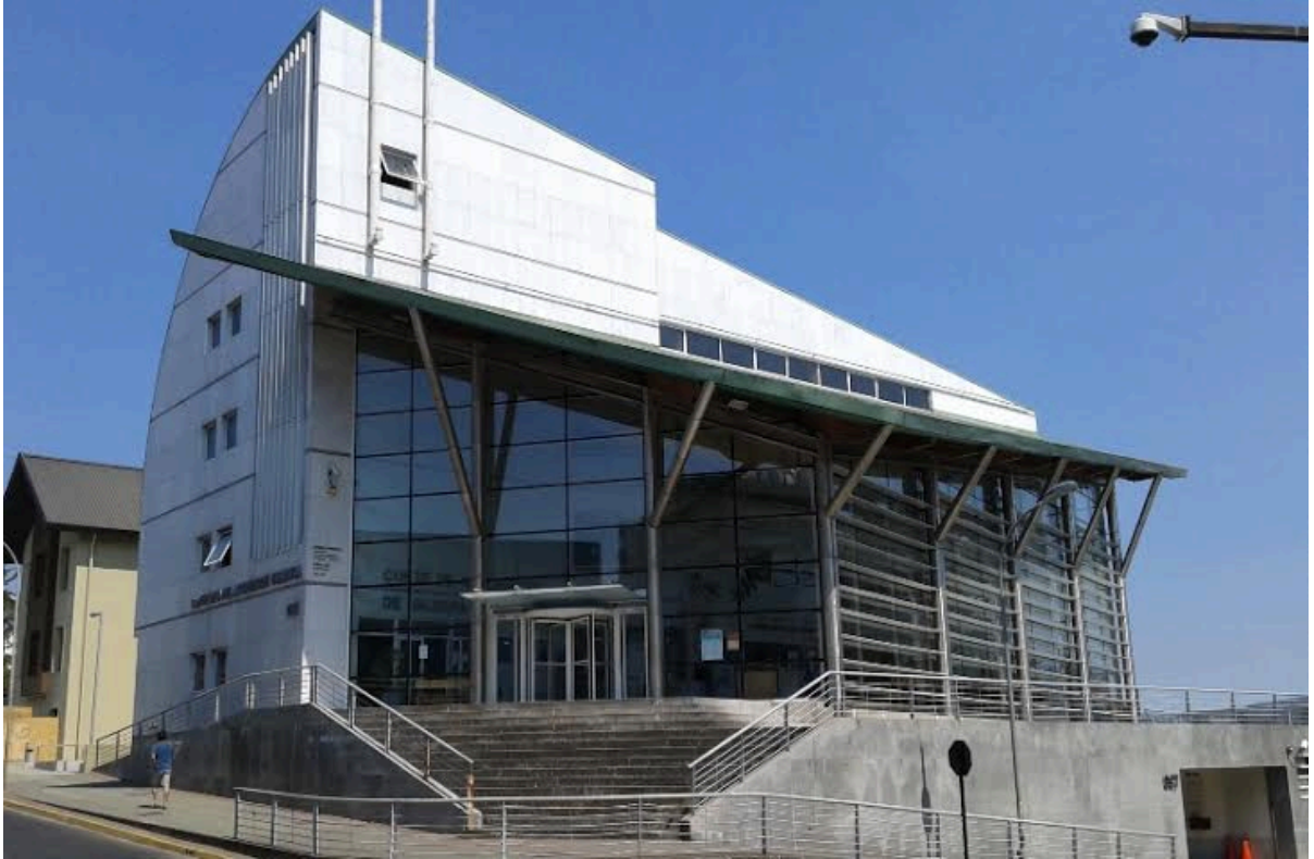
Corte de Apelaciones de Valdivia.
