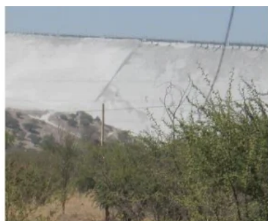
Figura 3a. Tranque de relaves Las Tórtolas de Minera Angloamericana, donde se observa fractura y hundimiento parcial de su muro de contención después del sismo de febrero de 2010.
