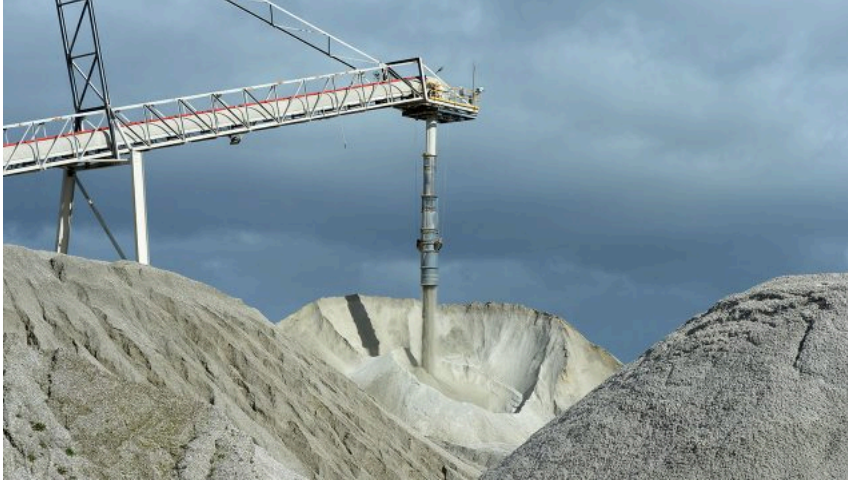
Mina de litio. Foto: Especial .
